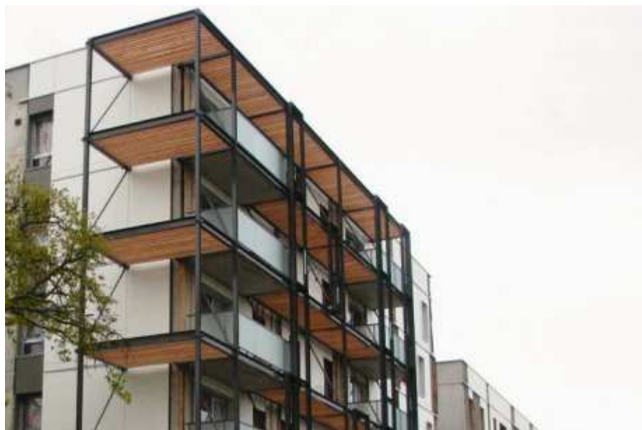
La dernière phase de renouvellement de la résidence Les Pins porte sur la construction de 206 logements collectifs, 21 logements individuels et quelques commerces. (photo O.D.)
